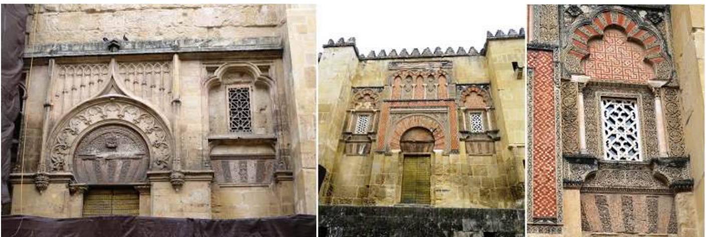
❶ Postigo del Palacio. 961-965. ❷ Puerta de San Ildefonso 961-965. ❸ Ventana derecha.
