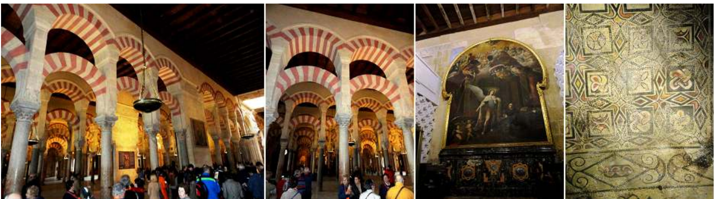
1 - 2 Los arcos (superior de medio punto e inferior de herradura) sobre columnas alguna visigodas y romanas, están recrecidos con pilares cuadrados para dar una mayor altura. 3 Capilla de San Agustín y Santa Eulalia. 4 Frente a estas capillas en el suelo de la nave se aprecia bajo cristal los suelos de la primitiva catedral visigoda de San Vicente realizados con cantos de colores.
