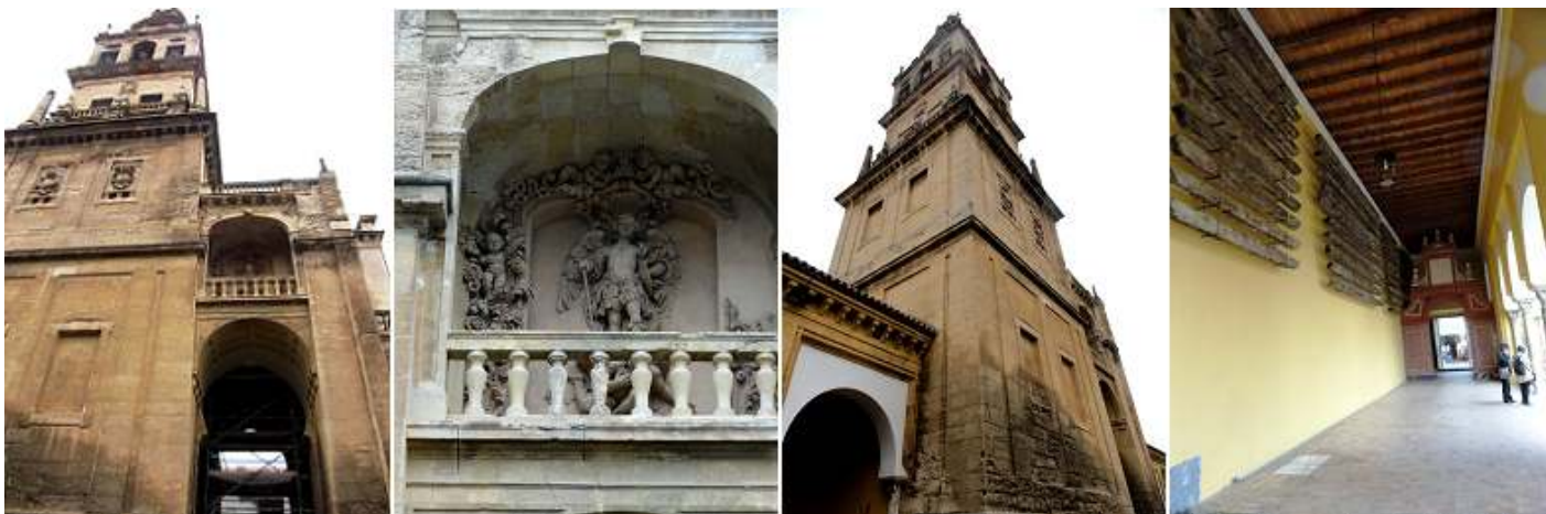
❶ Parte interior de la portada del Perdón con otro arco de herradura mucho más sencillo, y sobre el mismo un nuevo arco rebajado con balaustrada y en su interior la imagen del arcángel San Miguel ❷ La torre adosada a la puerta con seis cuerpos de planta cuadrada. Que cubre el alminar con ella, en estilo barroco. ❸ Galería interior de este lado con el pórtico de la leche al fondo, el patio de los naranjos está rodeado por tres galerías llamadas saqifas, para albergar a los fieles.
