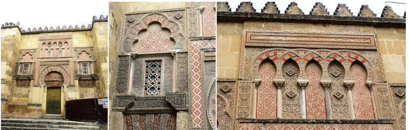
❶ Puerta del Espíritu Santo, 961-965. ❷ Detalle de la ventana en el lado izquierdo. ❸ Parte superior con una arcada de arcos entrelazados.
