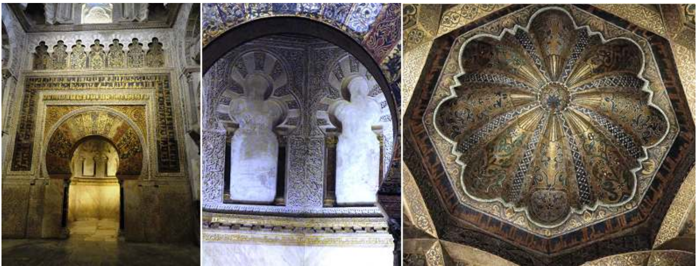
❶ Su portada con una exquisita decoración combinado la yesería, la cerámica y la pintura con zócalos de mármol en la parte inferior. Con un arco de herradura. ❷ Interior de los arcos ciegos poli lobulados de sus lados. ❸ Cúpula existente ante la portada bellamente decorada.
