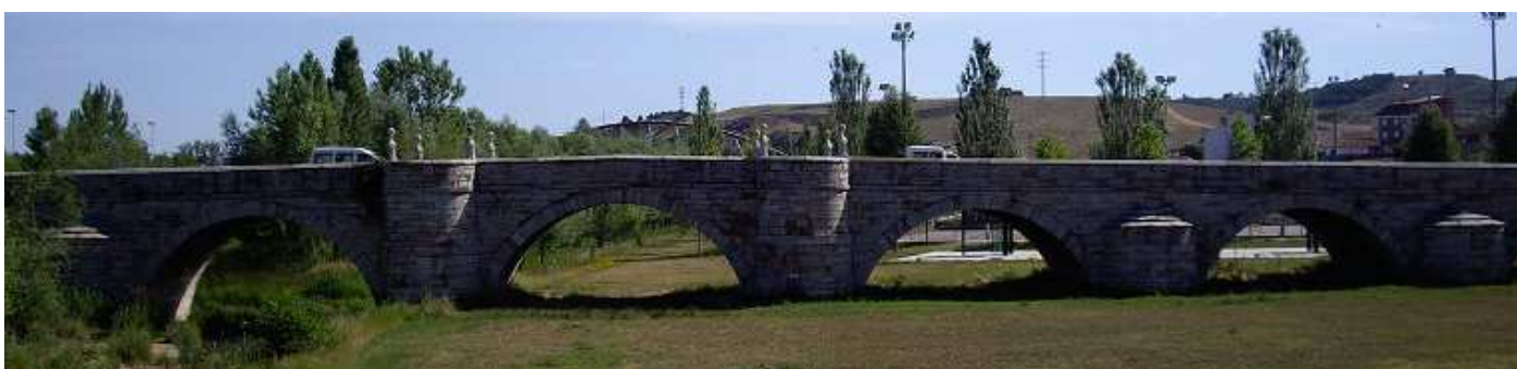
Puente de San Marcos de León. Lugar a la entrada por el que los peregrinos pasan siguiendo el Camino de Santiago.
