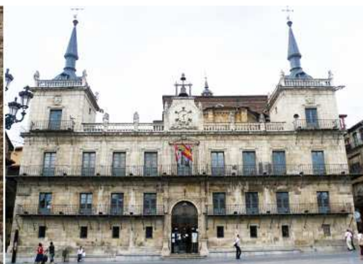
2 Edificio del Ayuntamiento.
